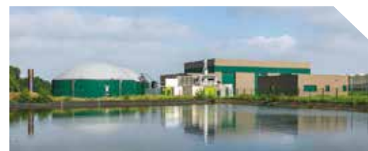
VUE GÉNÉRALE DES ÉLÉMENTS PRINCIPAUX DU SITE. BÂTIMENT ACCUEIL/LABO, BÂTIMENT RÉCEPTION. AU CENTRE : VALORISATION BIOGAZ PAR COGÉNÉRATION. À GAUCHE : DIGESTEURS.
